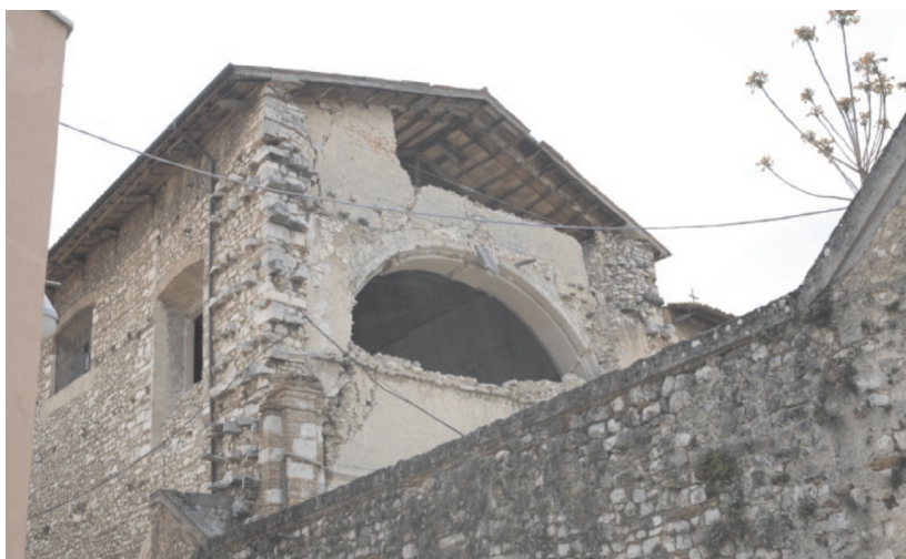
Figura 9. Danneggiamenti in corrispondenza dell'arco trionfale.
