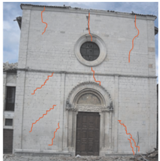
Figura 5. Danno riconducibile alla risposta nel piano della facciata.
