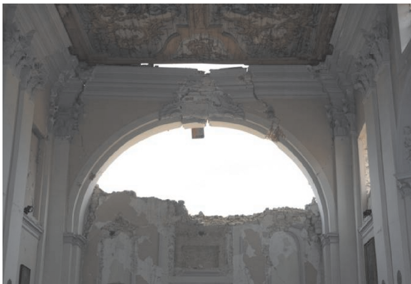
Figura 6. Danneggiamento dell'arco trionfale.
