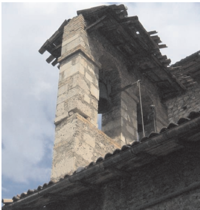
Figura 8. Danneggiamento nella vela campanaria.
