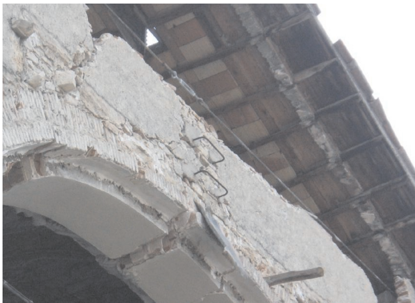
Figura 10. Copertura della chiesa: nuova struttura in cemento armato e travetti lignei della copertura originaria.
